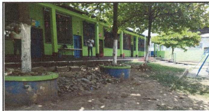
Foto 6: VISTA PANORÁMICA DE LA ESCUELA
