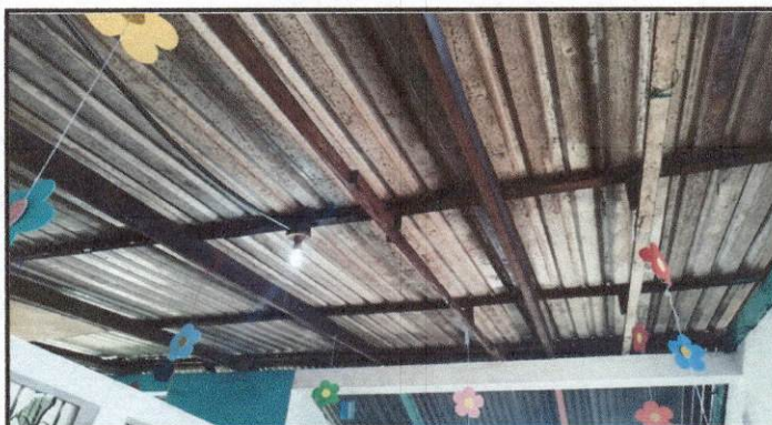
Foto 3: PANORÁMICA ESTADO ACTUAL DEL TECHO EN AULA 5
